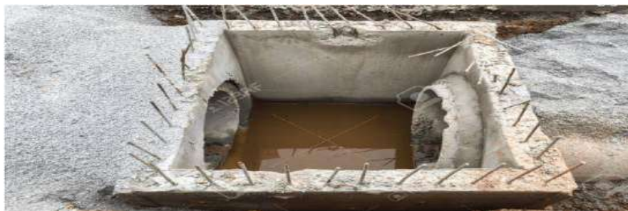
Fig 20:- Manhole
